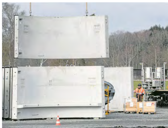
Modul auf Modul gesetzt: Spätestens im September sollen die Anlagen in Betrieb gehen.
