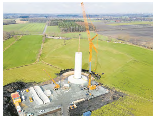
Aus der Luft sieht die Baustelle winzig aus. Aber der Anlagenturm wächst sichtbar in die Höhe.
