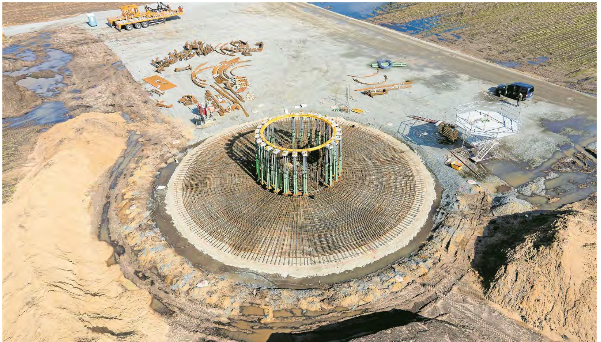
Das Fundament für ein neues Windrad mit 241 Metern Höhe. Eine Anlage bringt nach dem Repowering so viel Leistung wie die elf Vorgängermodelle zusammen.
